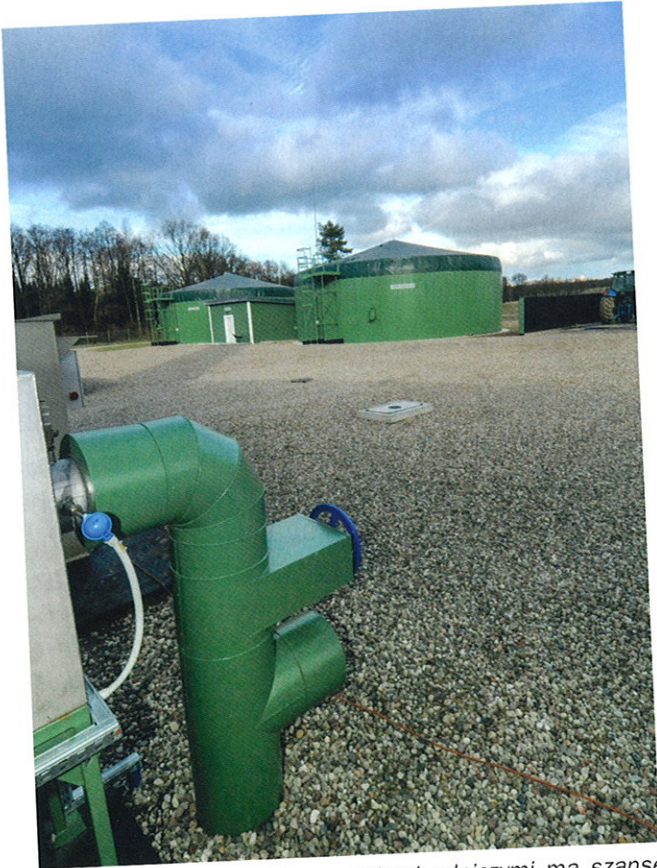
Czarne chmury nad biogazowniami rolniczymi ma szansę rozwiązać rządowy projekt nowelizacji ustawy o OZE
